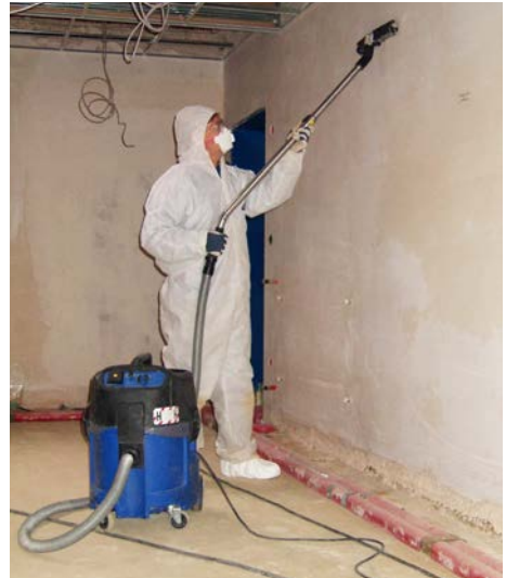
Abb. 7 Feinreinigung des Sanierungsbereiches
